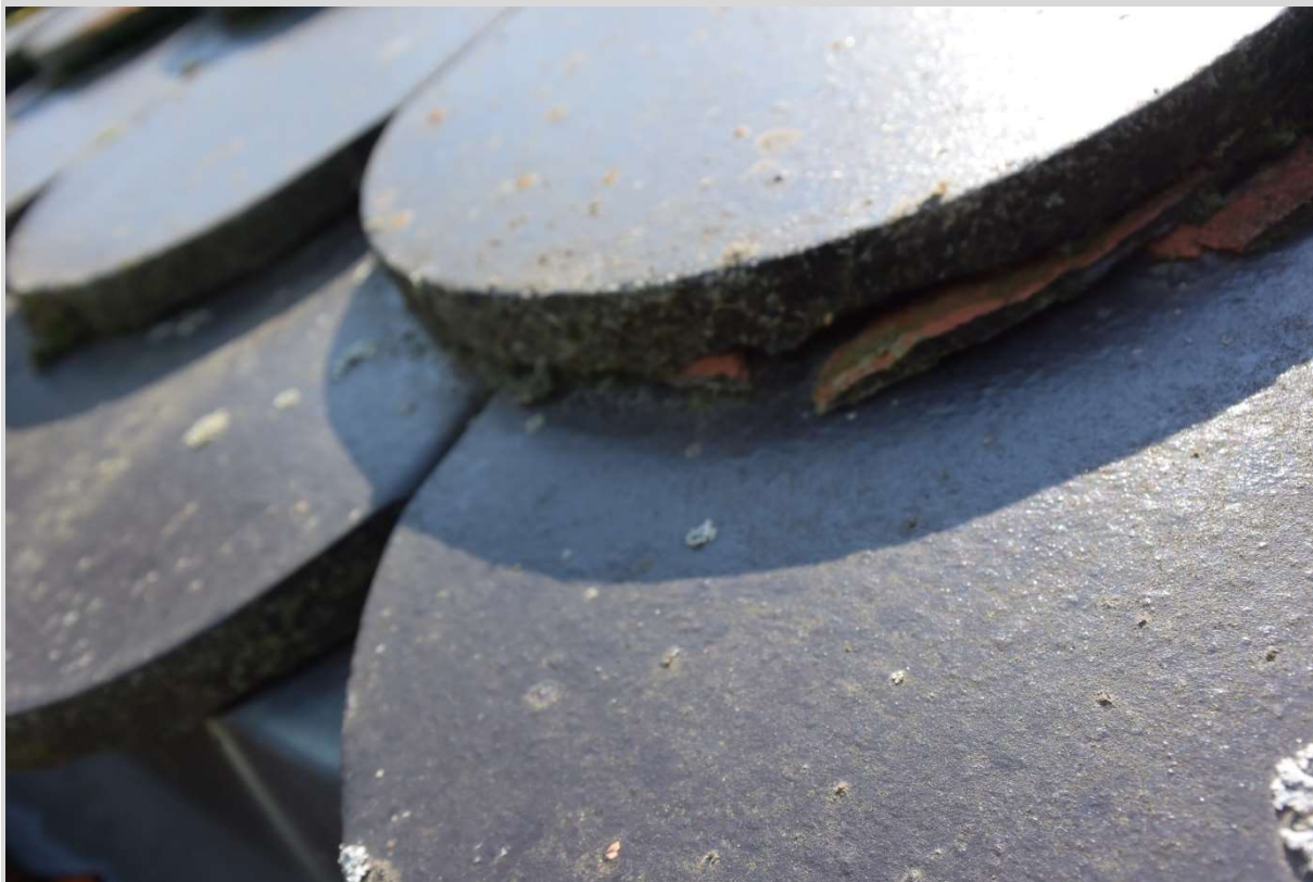
Abbildung 8: Abspregung unterseitig an engobierten Biberschwanz-Ziegelkanten
