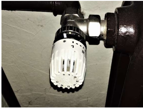
Abb. 3: Thermostat mit Frostschutz-Einstellung
